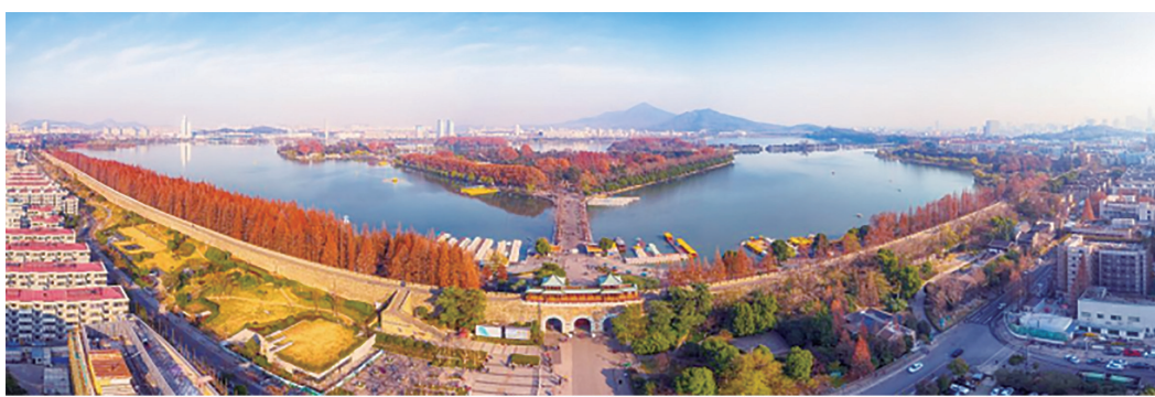
南京城墙航拍图
