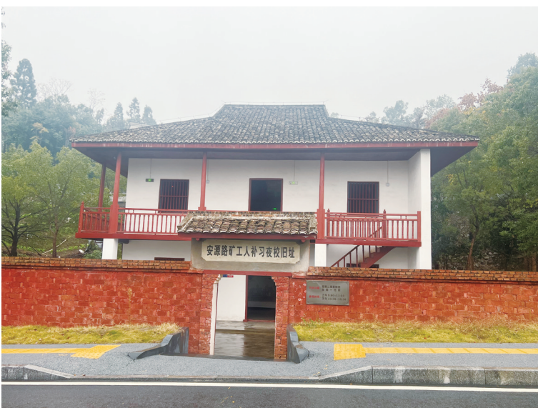
安源路矿工人补习夜校旧址
