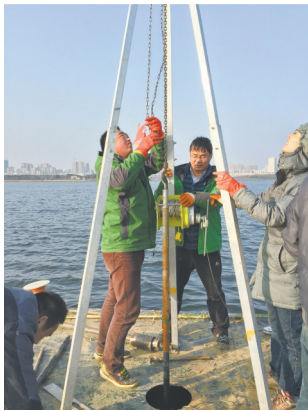
图十三 搭建水上平台进行钻探
